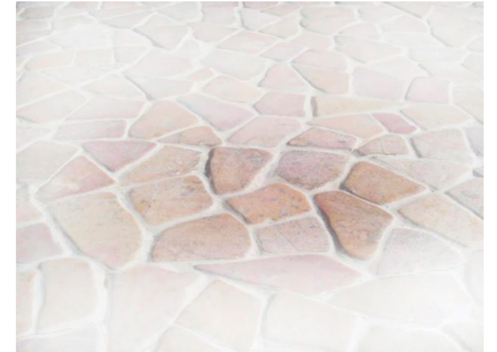
目地材は必ず充填してください
